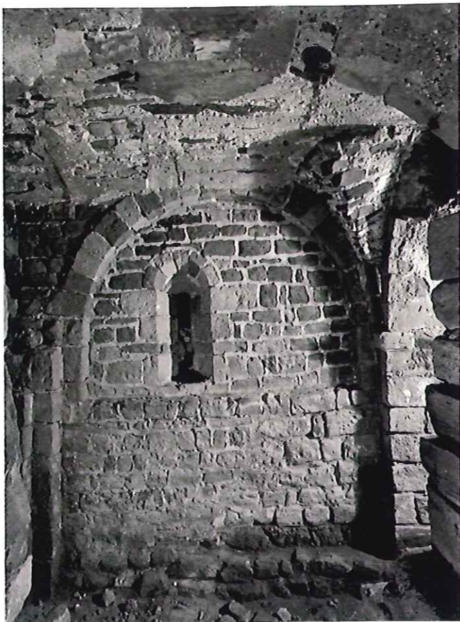
Fig. 7 : Vue intérieure, face nord, de la crypte pré-romane de l'église.
