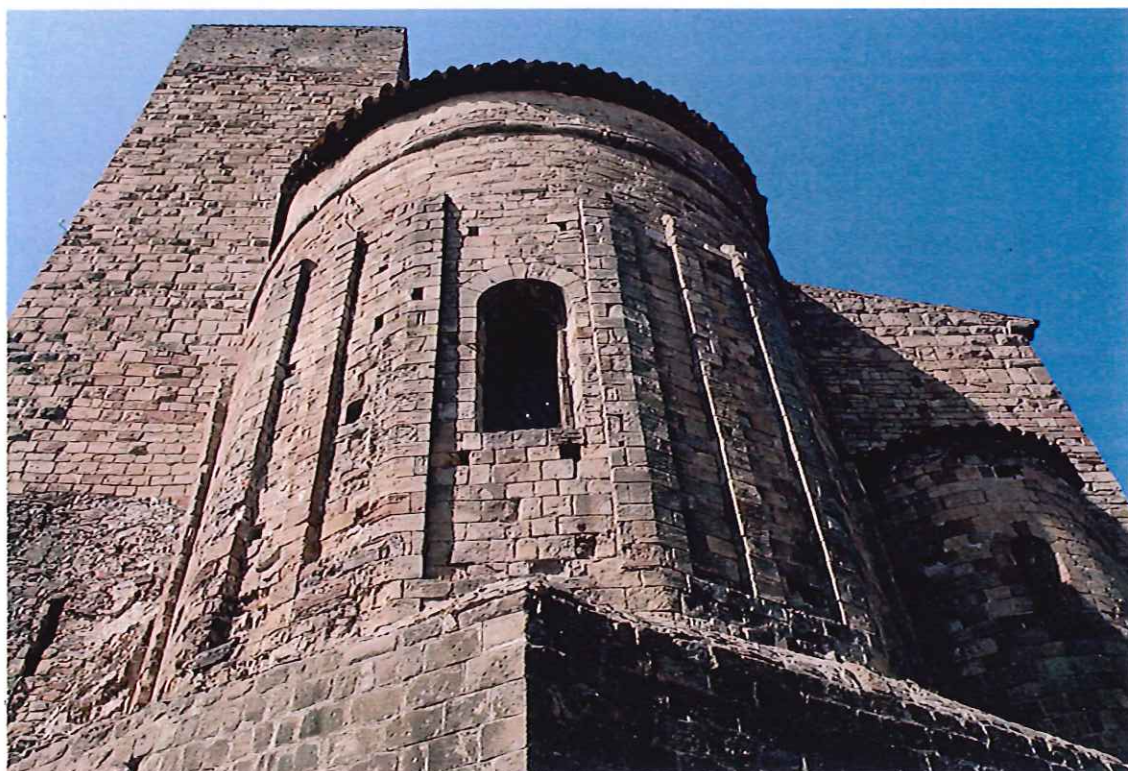
Fig. 8 : Abside et absidiole de l'église romane (XII e s.) Au second plan, la tour-clocher du XIII e s.
