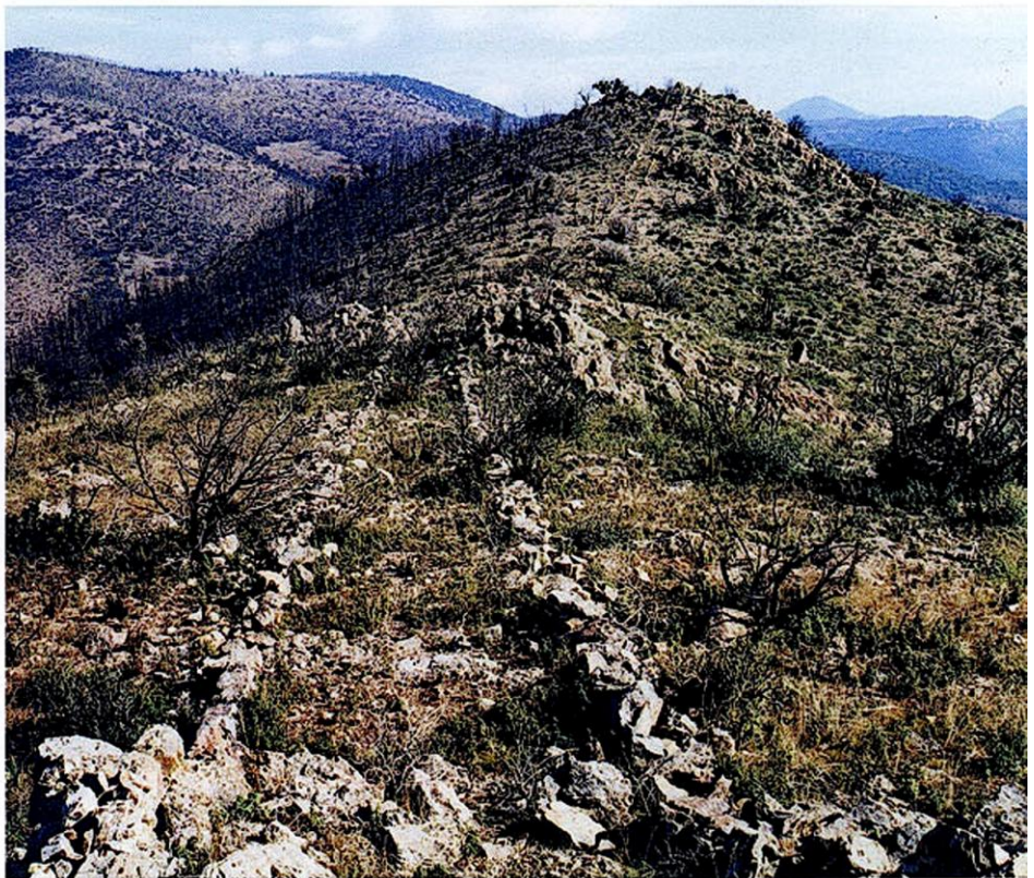
Ci-dessus. Le mur-double découvert sur le massif de l'Estérel. Photo des auteurs.
