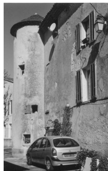
Une des quatre tours d'angle du château de Néoules.
