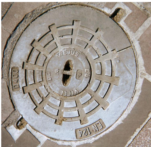
Regard assainissement rue Espitalier Centre ancien de Fréjus
