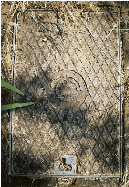
Trappe réseau téléphonique en ciment armé Enceinte de l'abbaye du Thoronnet
