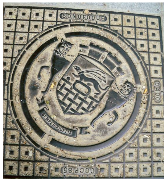
Trappe de visite du réseau des égouts Saint-Malo
