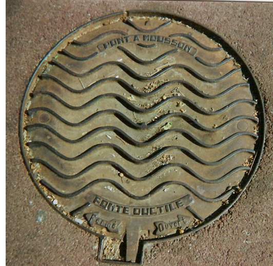
Regard PAM eaux pluviales, rond-point de la gendarmerie, à Fréjus-Plage
